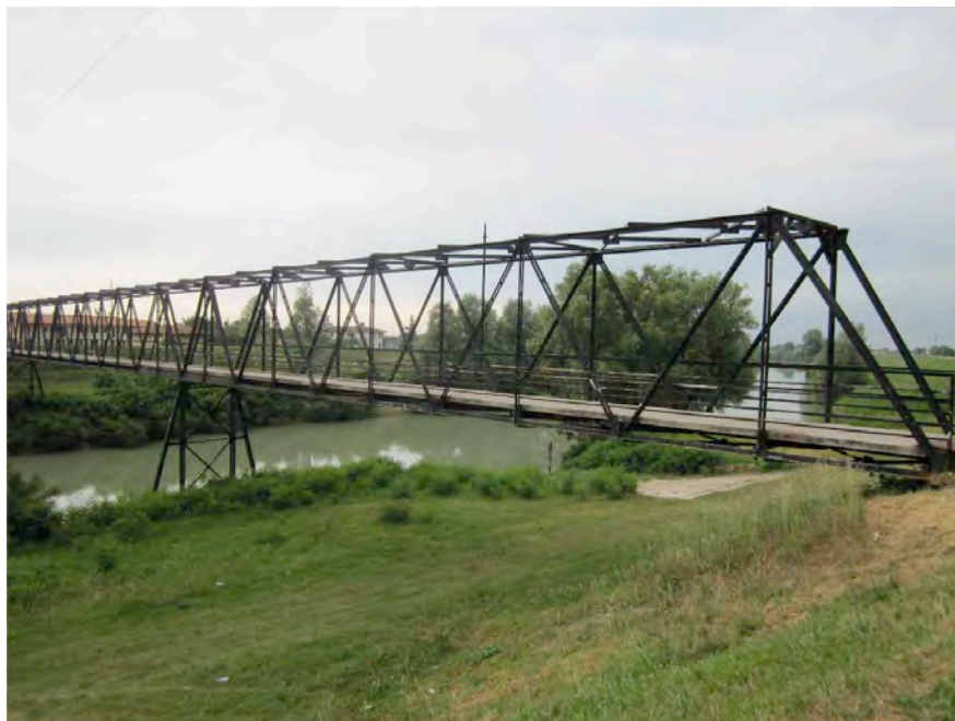
Foto 24 – Ponte ciclo-pedonale sul Livenza (collegamento con GiraLivenza)
