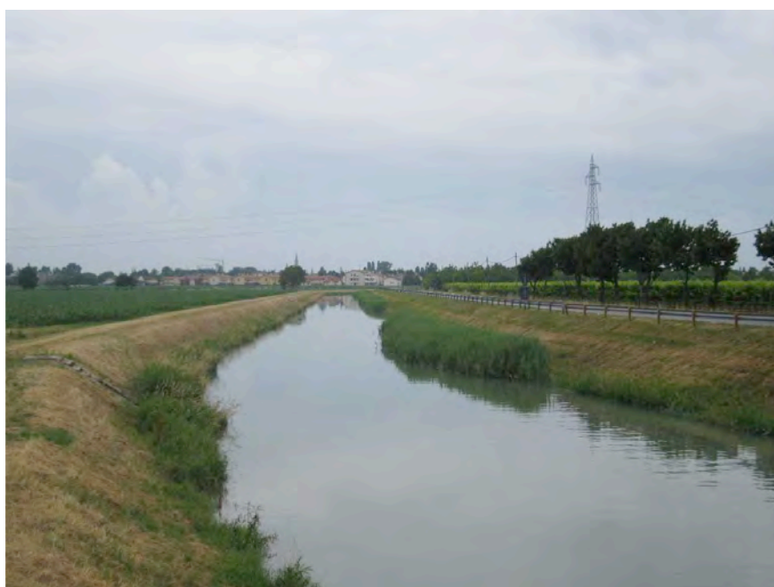
Foto 17 – Veduta del canale Brian (con Cessalto sullo sfondo) dal ponte di via Callunga
