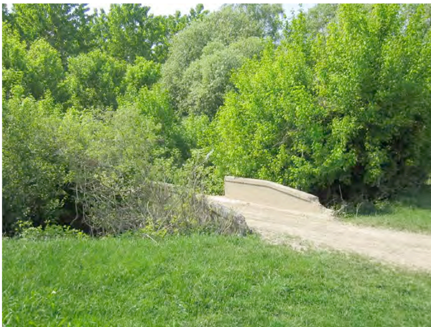
Foto 30 – Il ponte della Piavolina sul Rasego nei Prà dei Gai
