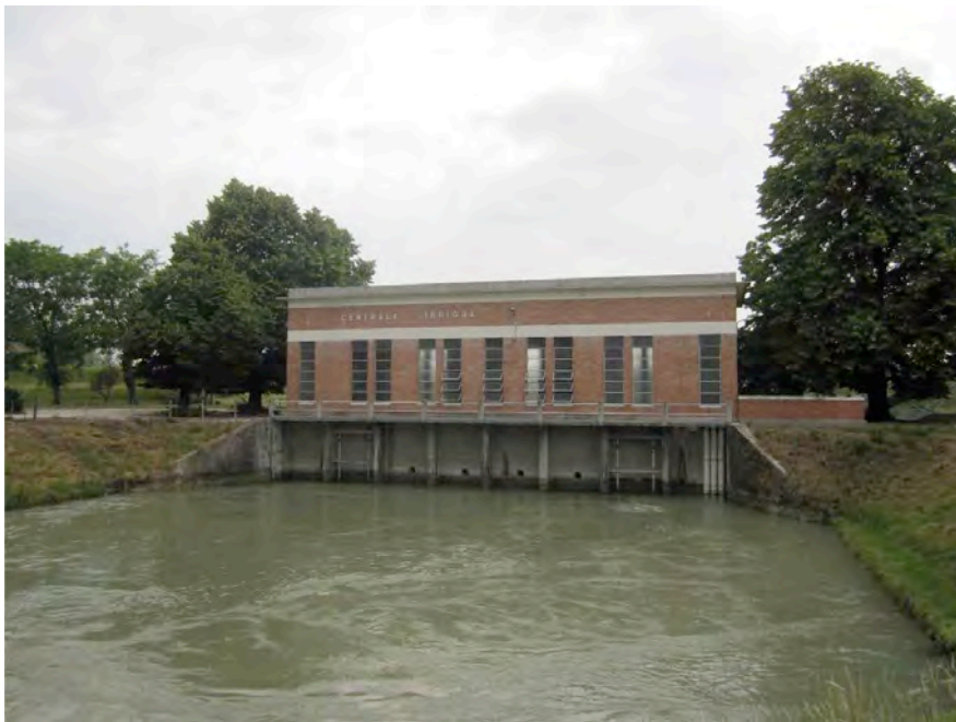
Foto 20 – La centrale irrigua a nord di Villanova
